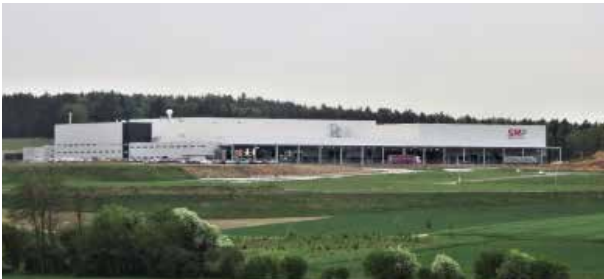
2013 – 2015 Neubau eines Industriekomplexes in Markt Schierling
